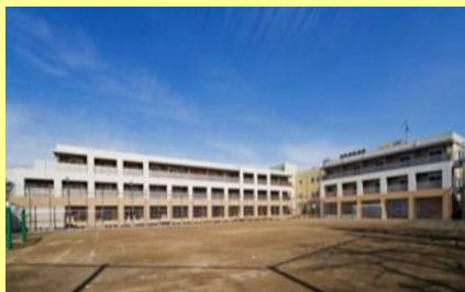
学校を改修して整備した事例
