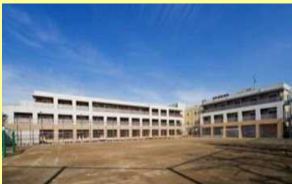
学校を改修して整備した事例
